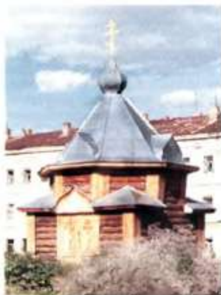
Часовня на месте разрушенного собора в честь Казанской иконы Божией Матери в Елабужском монастыре. Фотография, 2009 г.
